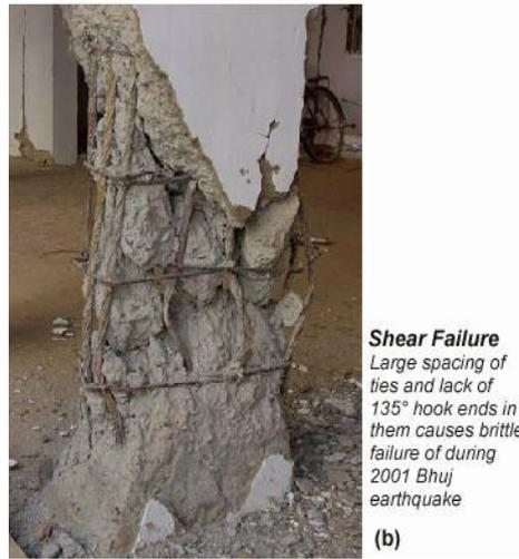
الشكل 2-1: انهيار أحد الأعمدة في زلزال بهاج Bhuj earthquake في الهند عام 2001
