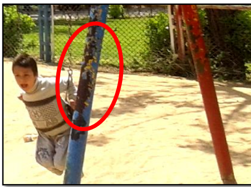
الشكل (4-25) تبيّن بعض العناصر المعدنية الصدئة
