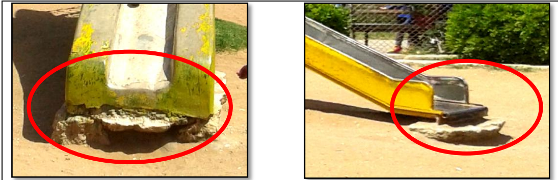
الشكل (4-20) و (4-21) يبينان بروز مادة التثبيت الإسمنتية
