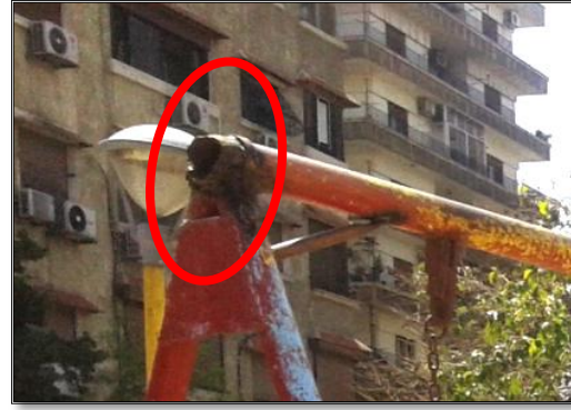
الشكل (4-24) يبيّن بعض عناصر أجهزة اللعب المتآكلة
