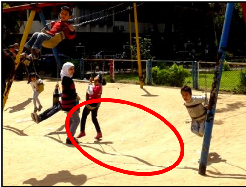
الشكل (4-27) يبيّن انحسار مادة الأرضية الواقية للصدّات (الرمل) تحت الأراجيح
