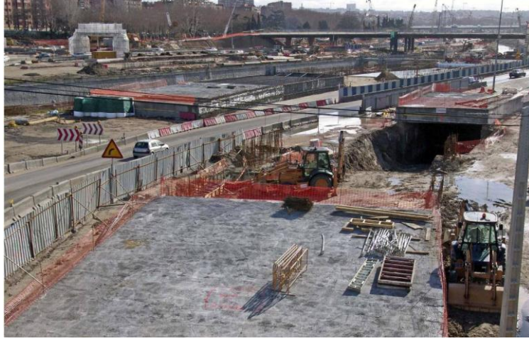
الشكل (٢-٨٤): يوضح أعمال البناء على النهر ٣٤
