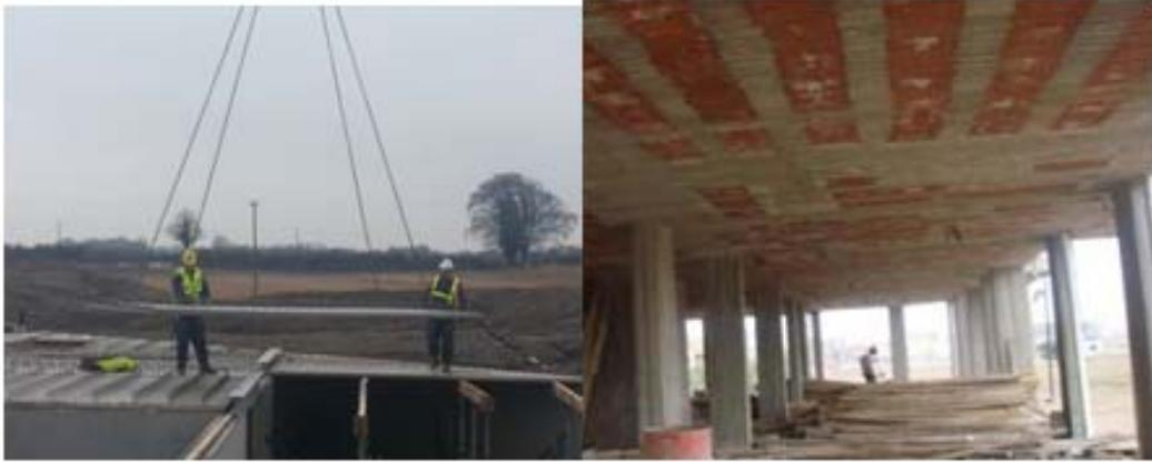
بلاطة الهوردي (*one-way ribbed slab*) البلاطة مسبقة الصنع (*Precast Slab*)
