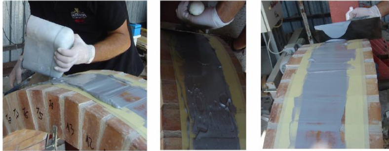
الشكل (١٠-١): استخدام الـ FRP في تدعيم الأقواس الحجرية (Ricamato, 2007)
