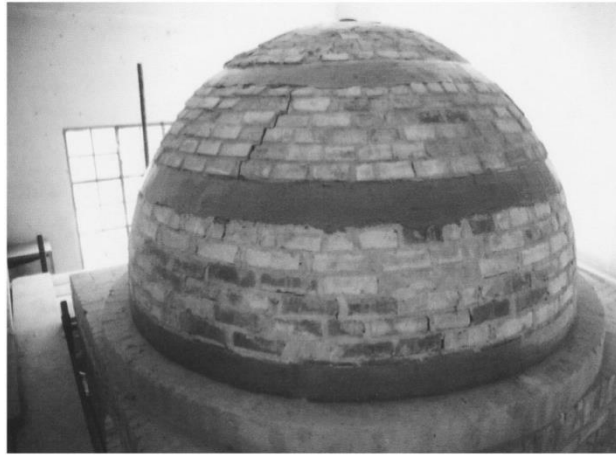
الشكل (١٢-١): استخدام الـFRP في تدعيم القباب (Foraboschi, 2004)
