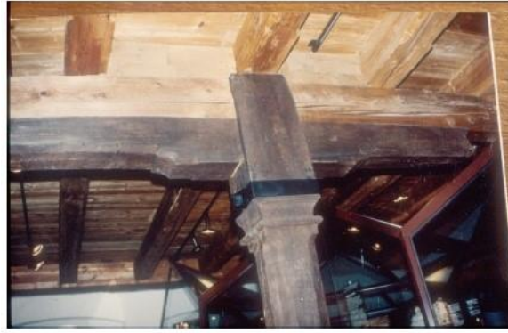
الشكل (٨-١): استخدام الـ FRP في تدعيم الأعمدة الخشبية (Steiger, 2002)
