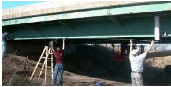
الشكل (٩-١): استخدام الـ FRP في تدعيم الجوائز المعدنية
