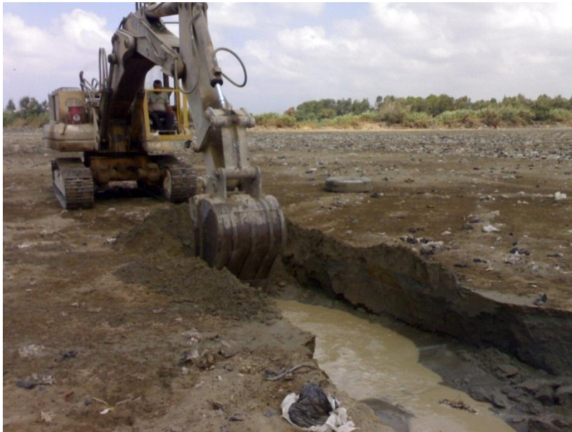
الشكل رقم (2-12): ظهور المياه الجوفية أثناء إنشاء حفرة تجميع الرشاحة.
