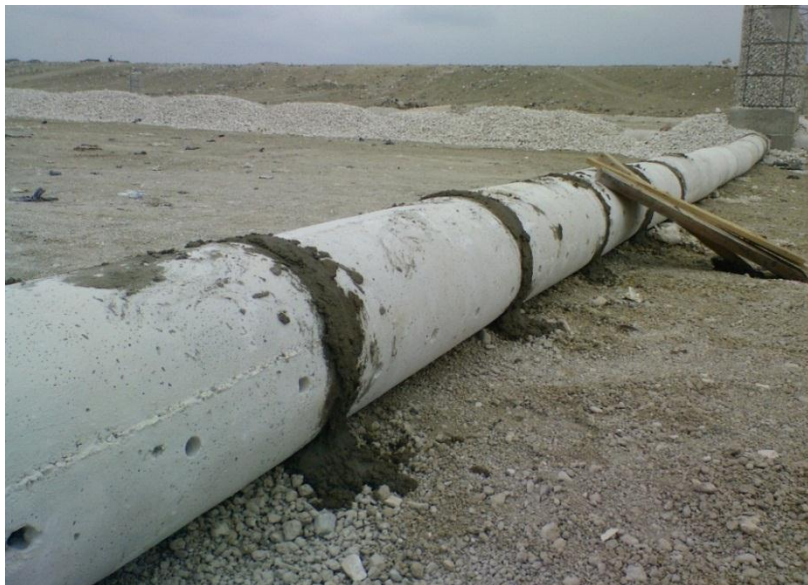
الشكل رقم (2-10): أنابيب جمع الرشاحة.
