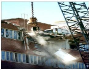
الشكل (1-11): الهدم الميكانيكي باستخدام الكرة الساقطة.
