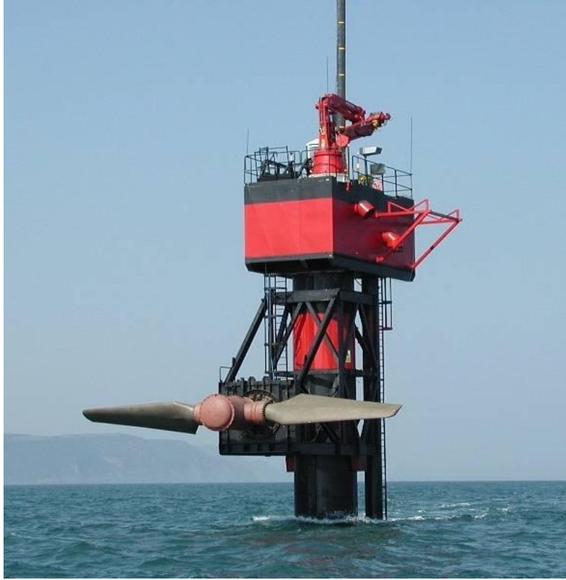
شكل (1-6) طريقة الأبراج للاستفادة من طاقة المد والجزر.
