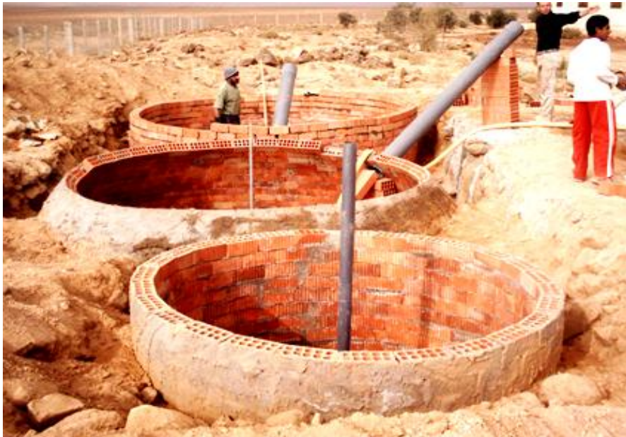
شكل (6-2) مراحل تنفيذ وحدة إنتاج الغاز الحيوي في محطة البحوث الزراعية في السماقيات / درعا.
