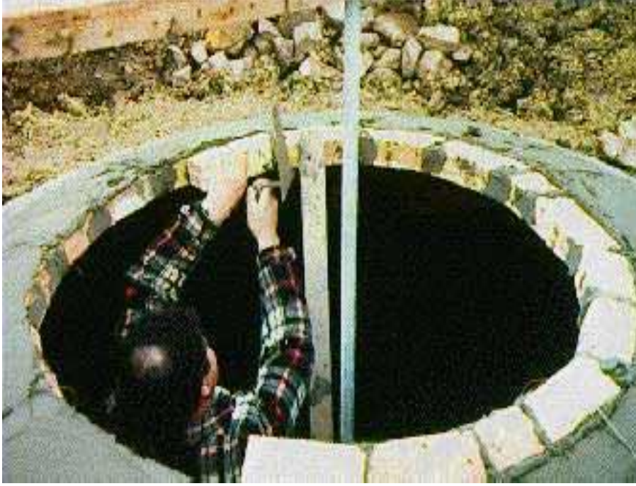
شكل (4-7) عامل يقوم ببناء مخمر نموذج قبة ثابتة في تونس.
