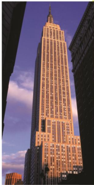
الصورة (15): المعمارين لامب وهارمون و Harmon, Lamb and ، بناء The Empire State Building في نيويورك، بلغ ارتفاعه 381 م، عام 1931.
