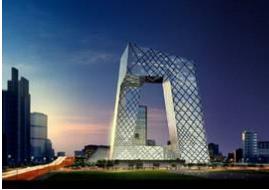
الصورة (90) تلفزيون الصين المركزي، بناء The CCTV building ، بإطارات إنشائية متكسرة وفراغ ضخم في مركزه
